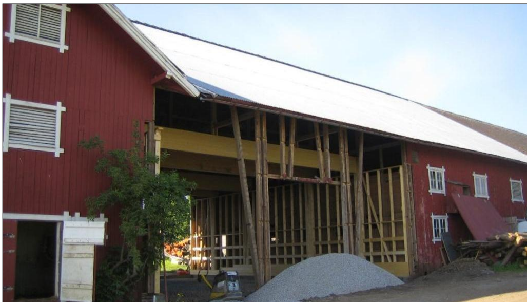
Driftsbygningen på Fokhol i Stange er under ombygging. Fire små rom blir til ett stort.
