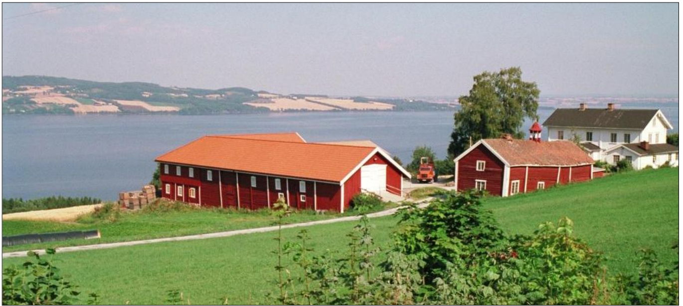
Fjøset på Gåserud i Østre Toten ble bygd helt om innvendig på 1990-tallet til en åpen hall for vedproduksjon.
